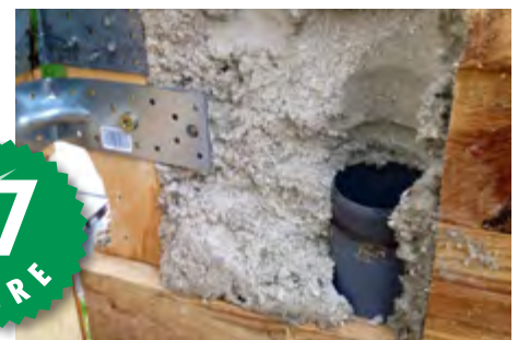
...keinerlei Spuren von Setzung oder Verformung auf.
