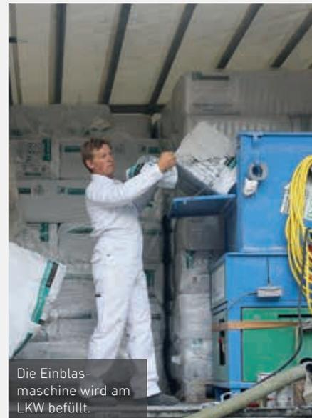
Die Einblasmaschine wird am LKW befüllt.
