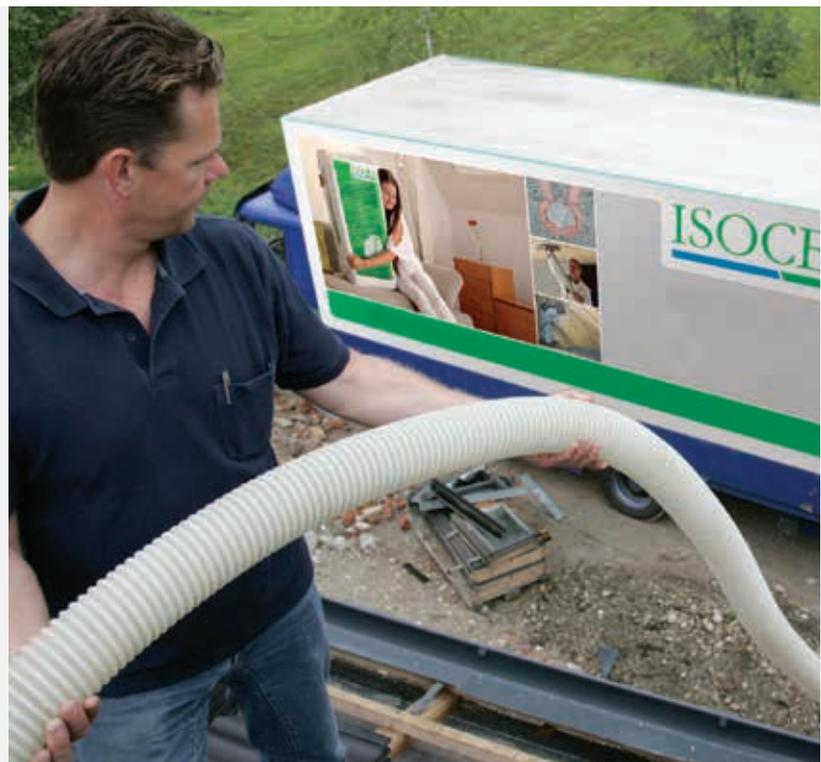
Der Einblas-Fachmann kommt mit seinem LKW auf die Baustelle und bringt gleich alles mit, was er braucht: Einblasmaschine und Zellulosefasern.
